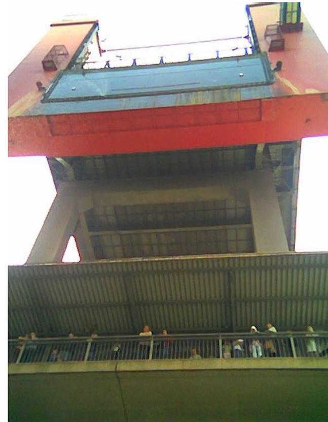
Auch hier hinter einem Frachter liegend, wurden wir in dem riesigen Stahlbetontrog wie in einem offenen Fahrstuhl über 38 Meter ins Unterwasser abgesenkt. Vom Einlaufen bis zum Auslaufen dauerte die Aktion nur runde 35 Minuten. Eindruckvoll war während des Absenkens der Blick auf den mit einem gewaltigen Stahlschott verschlossenen Kanal.
